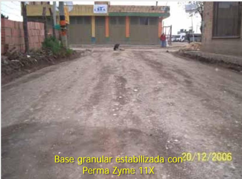
Base granular estabilizada con *Perma Zyme 11X* 20/12/2006
