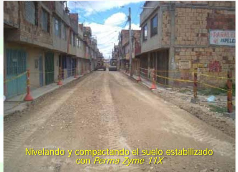
Nivelando y compactando el suelo estabilizado
